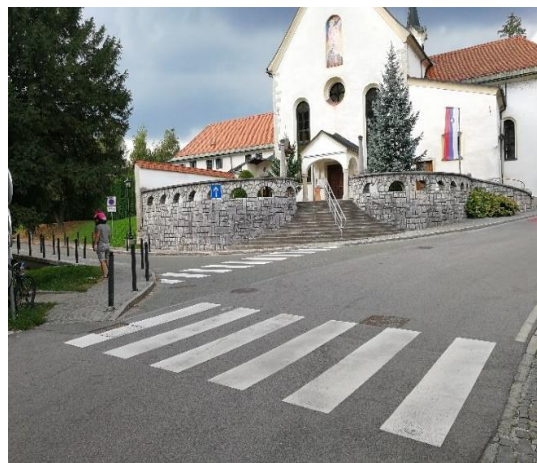
Slika 19: Prečkanje ceste pred kamnitim mostom
